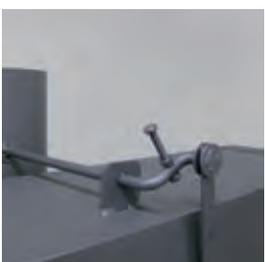
RÉGLAGE DU CLAPET DE FUMÉE
